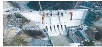
25年間にわたって続いた長島ダムの建設工事。チームの一員として惜しみなくノウハウを提供した。
