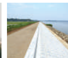
濁沼河川災害 復旧工事
