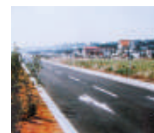
大洗町街路改良工事
