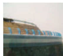
大洗町海岸防災工事
