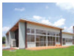
医療センター新築工事
