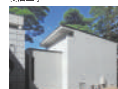
博物館改修工事
