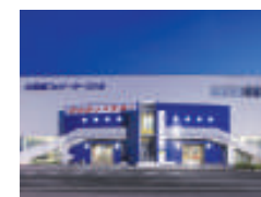
フェリーターミナルビル 復旧工事
