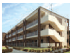
公営住宅建設工事
