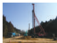
地盤改良工事
