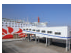
フェリーターミナルビル 人道橋復旧工事
