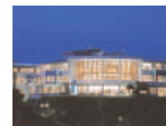
中学校改築工事
