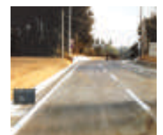
美野里町道路工事
