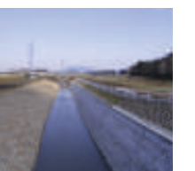
谷田川河川改修工事
