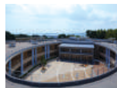
小学校改築工事
