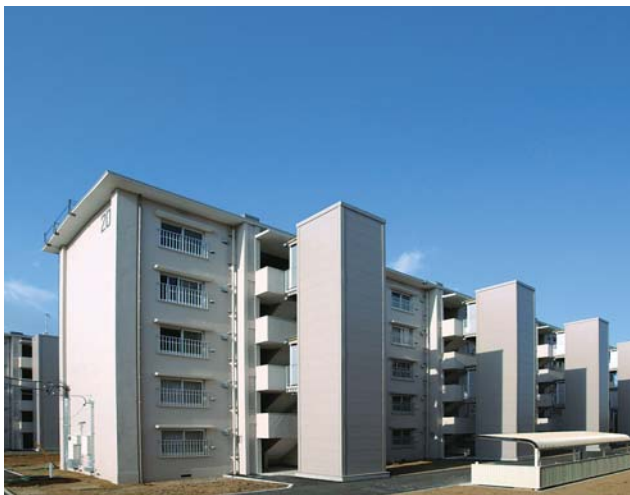
上飯田住宅改善工事
