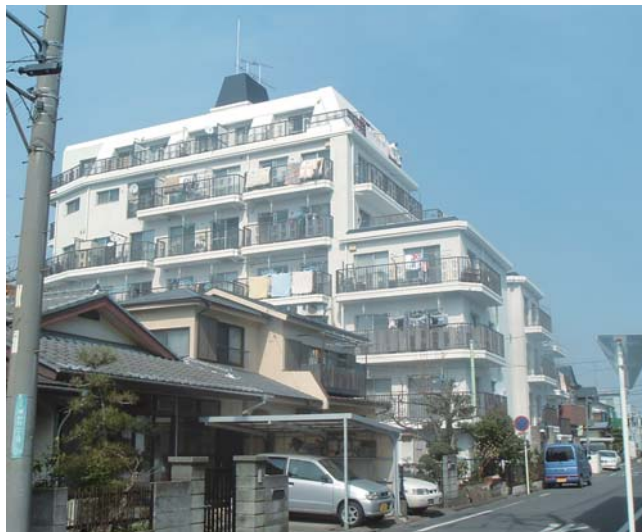
ヴィラ横山台大規模修繕工事（外断熱工法）
