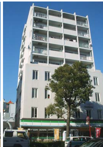
ハイレイフ山下町外壁他改修工事
