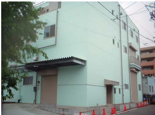
久我工場(設計・施工)
