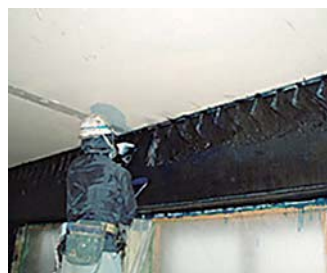
炭素繊維シート巻き(梁)
