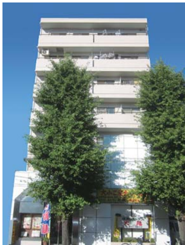
コスモハイツ上原大規模修繕工事
