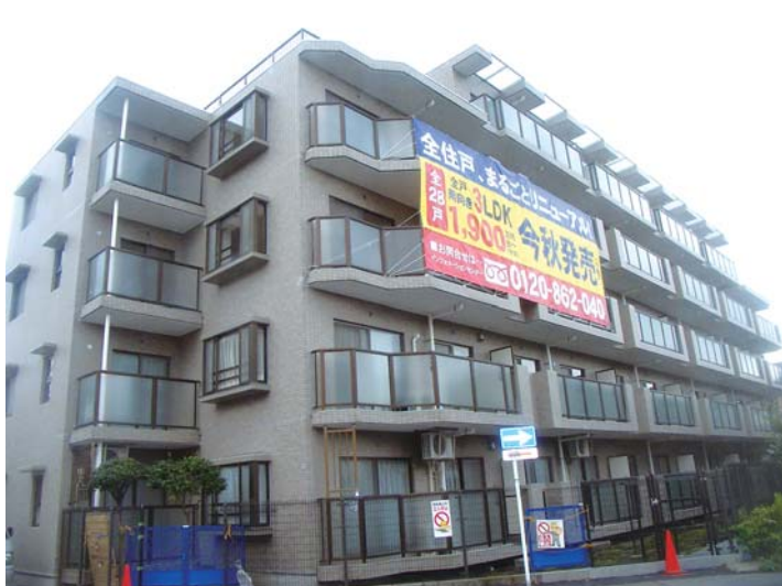
ベルググランデ小田急相模原改修工事
