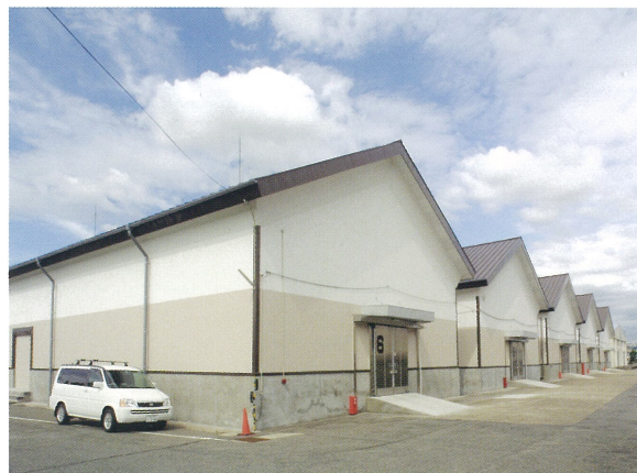
外部改修施工例
