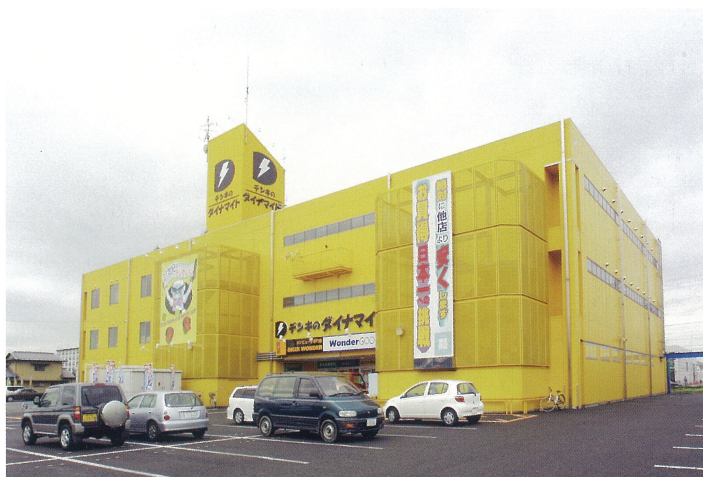
外部改修施工例
