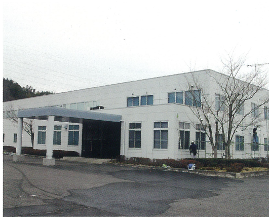
外部改修施工前
