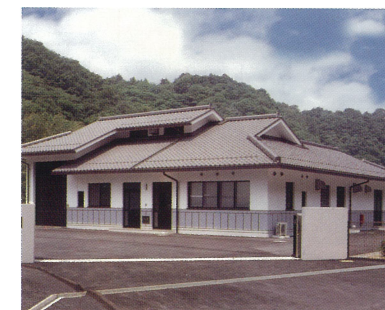
農業集落排水処理施設 [勝央町]
