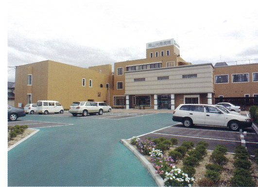
外部改修施工例
