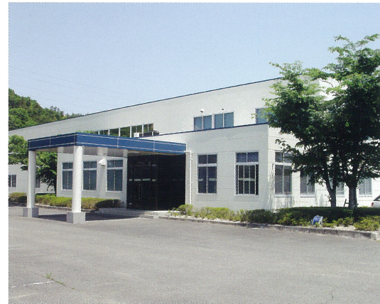
外部改修施工後
