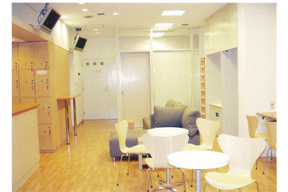
内部改修施工例
