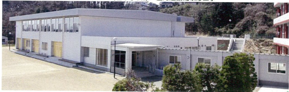
大崎市立鹿島台小学校様 屋内運動場改修工事
