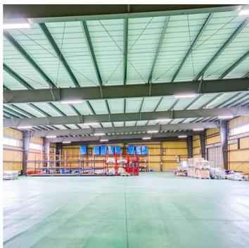
自社開発した構造解析ソフトでフレーム断面を算出超高層ビルや橋梁で用いる高張力材を採用する事で最大無柱スパン60mを、中間柱ありで120mの大空間を実現しました。
